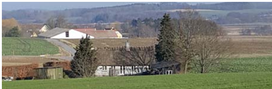
Huset på Lunderødvej 82 lidt uden for Marup, som Salomon Frederiksen lod bygge. Foto: Inge-Lis Madsen, 2019.
